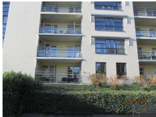
Foto van de achtergevel
